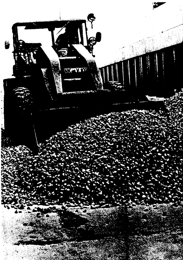
Bild 4: Einbau des Schotterbetts in einen mit PUR-Matten ausgekleideten U-Bahn-Schacht [4]
